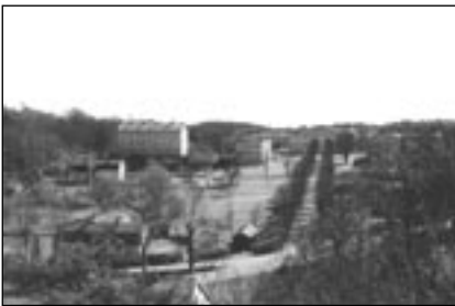
Vy över Ankarhuset (till vänster) och Södra kasernen med flankerande kasernlängor (till höger)
